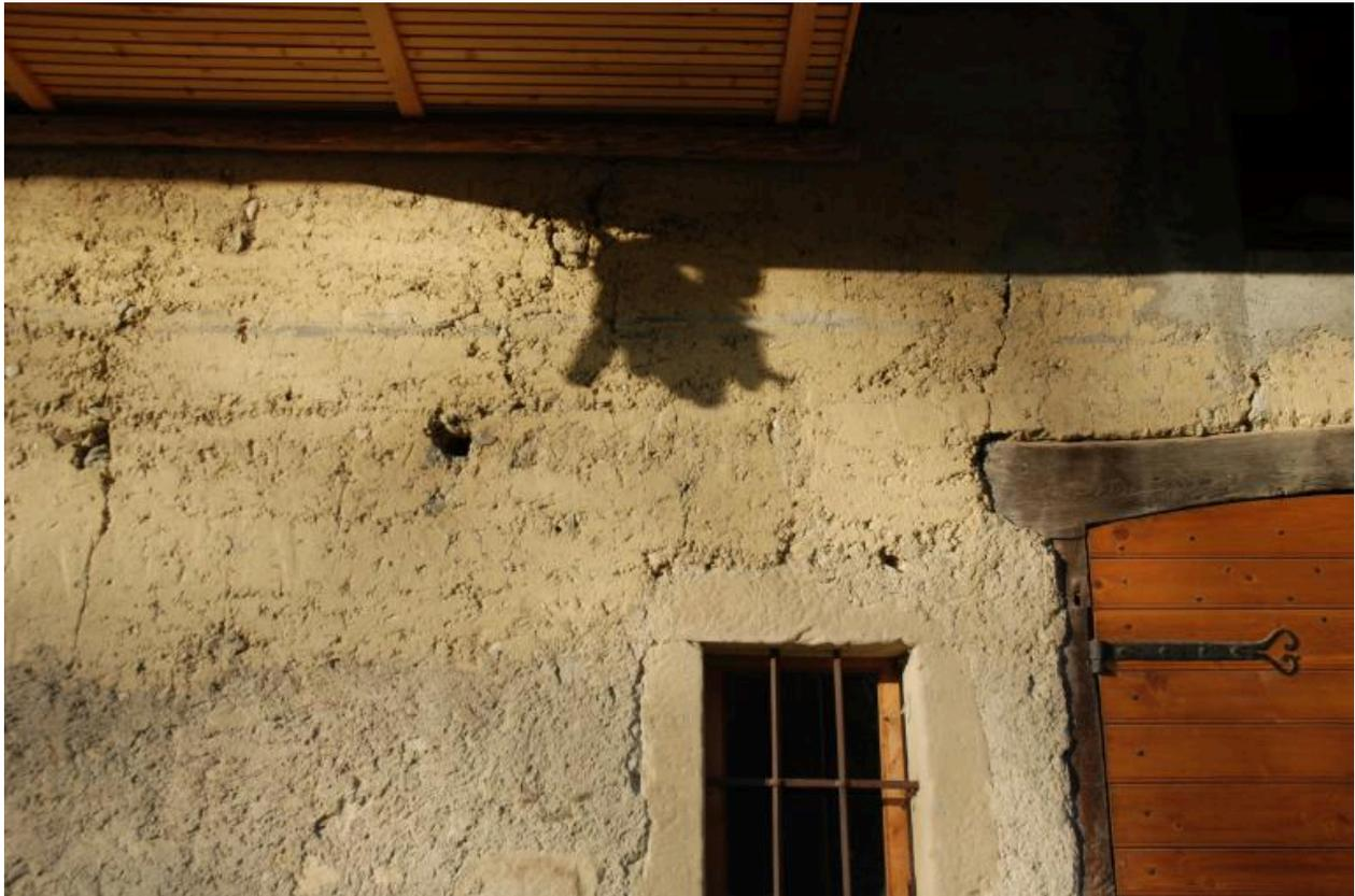
Détail de matériaux : mur en pisé, encadrement de fenêtre en molasse, porte de grange en bois (2016 A1 31).
