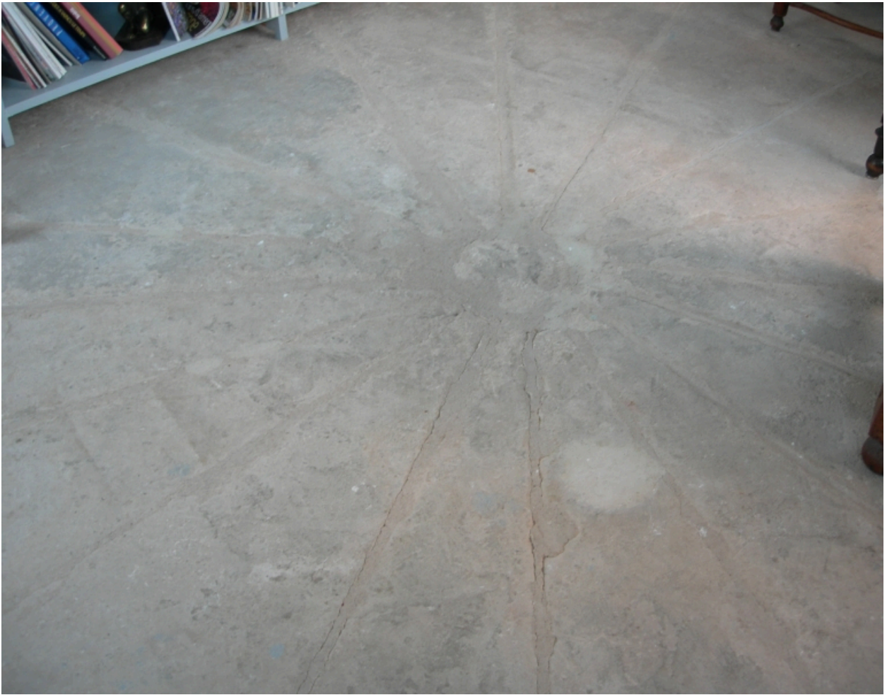
Lanterne d'escalier : vue du sol en dalles de pierre rayonnantes.
