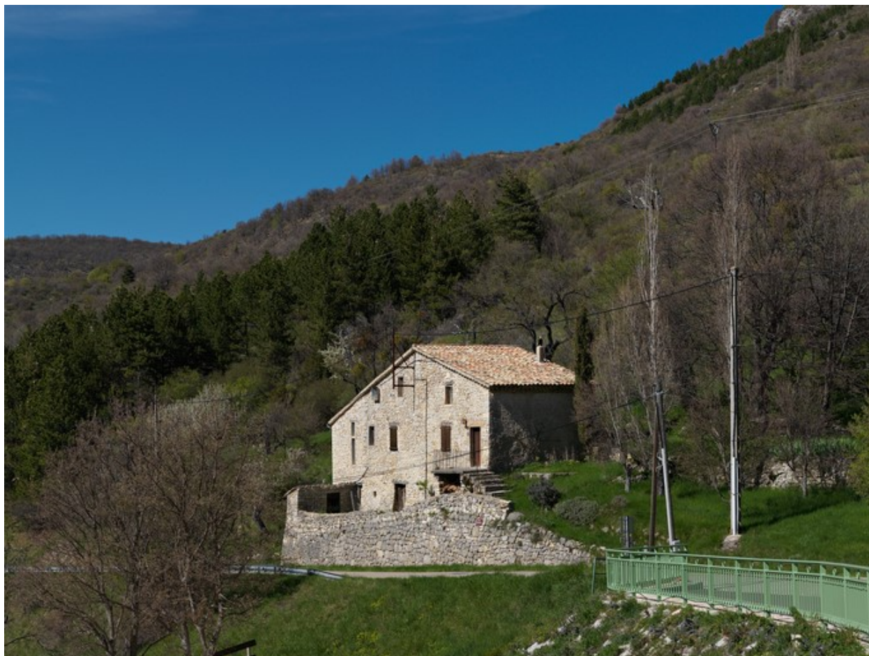
Vue de situation prise du sud-est.
