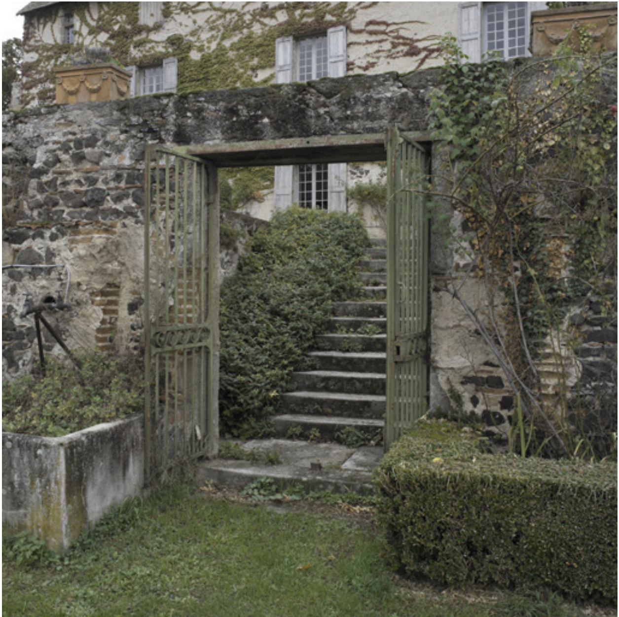
Vue de l'accès à la terrasse depuis le jardin.
