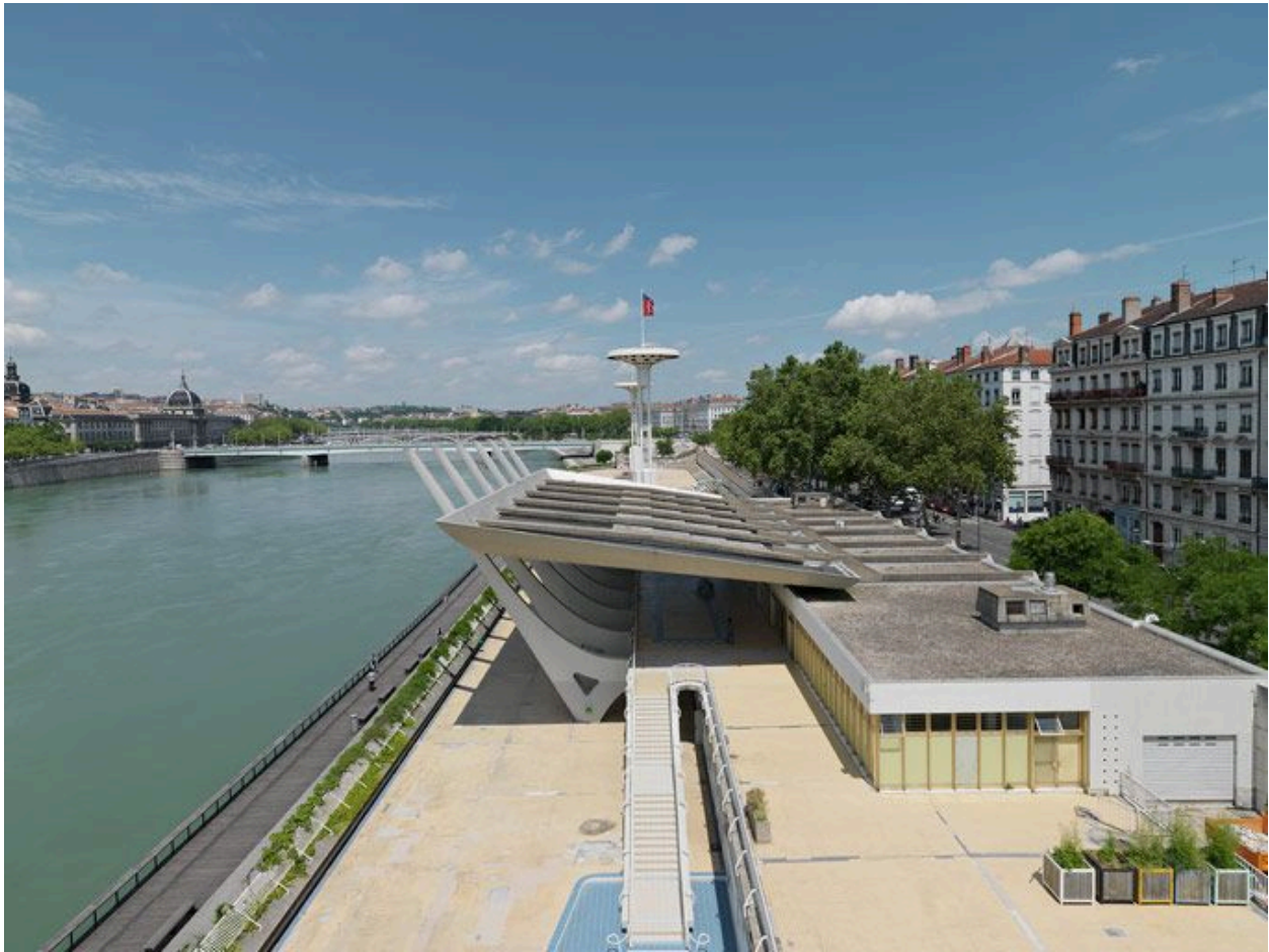
Vue du bâtiment d'exploitation depuis le sud (état en juin 2012).
