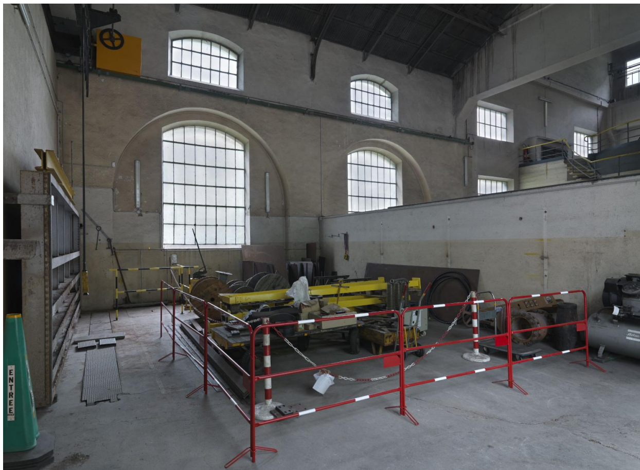
Baies de la salle des machines
