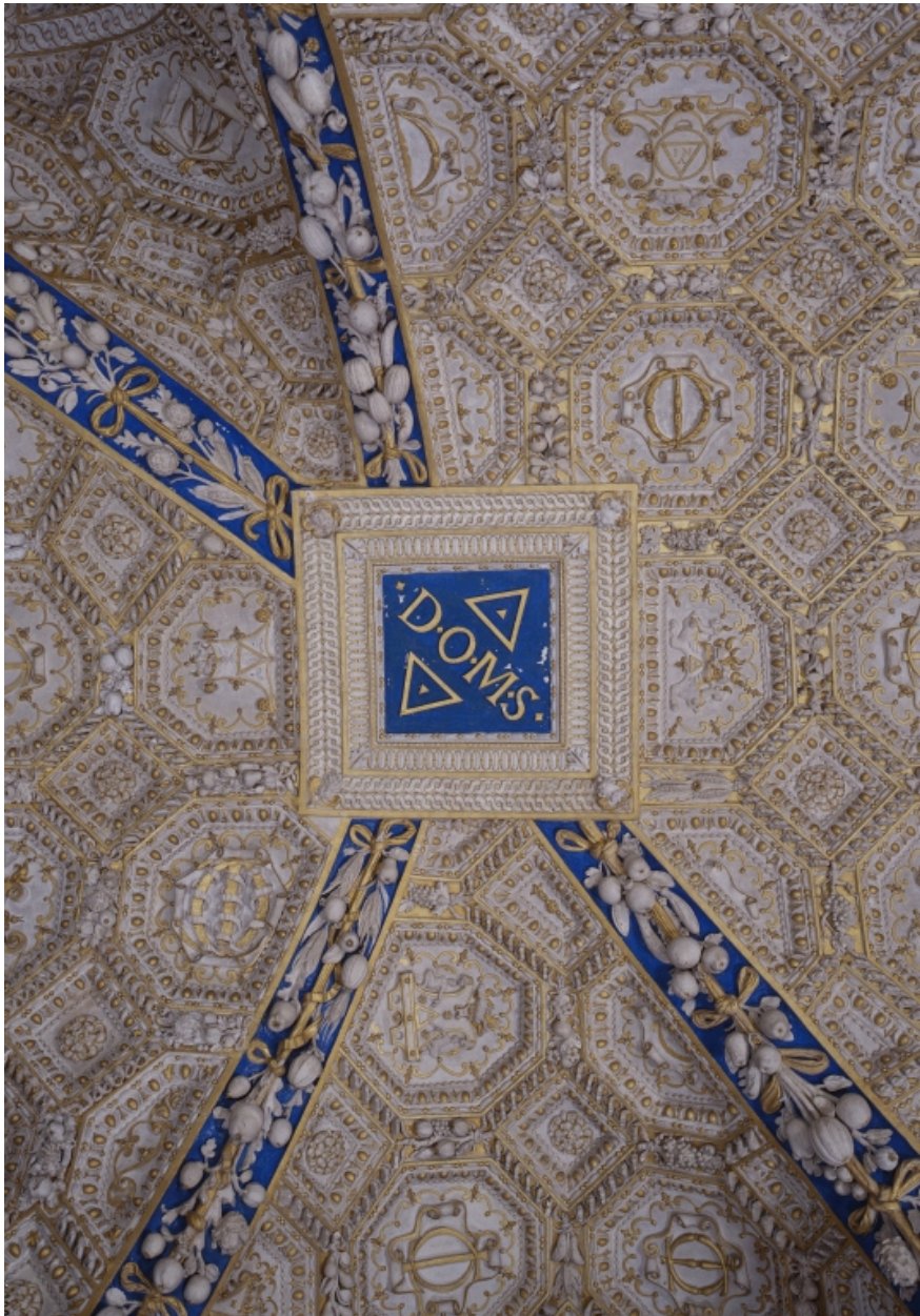
Vue de détail de la clef de voûte.
