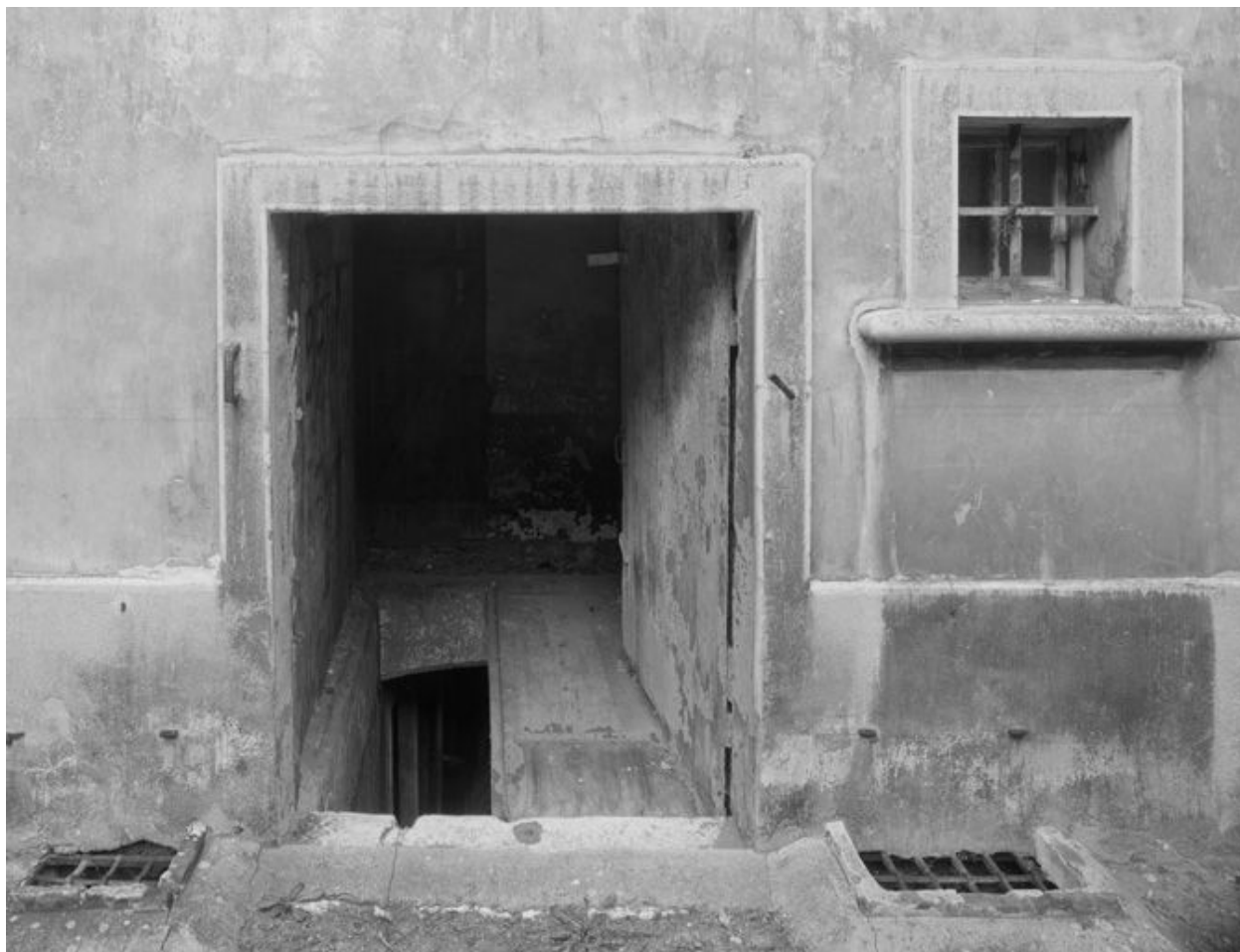
Corps de bâtiment est : entrée sud avec départ de l'escalier vers la cave
