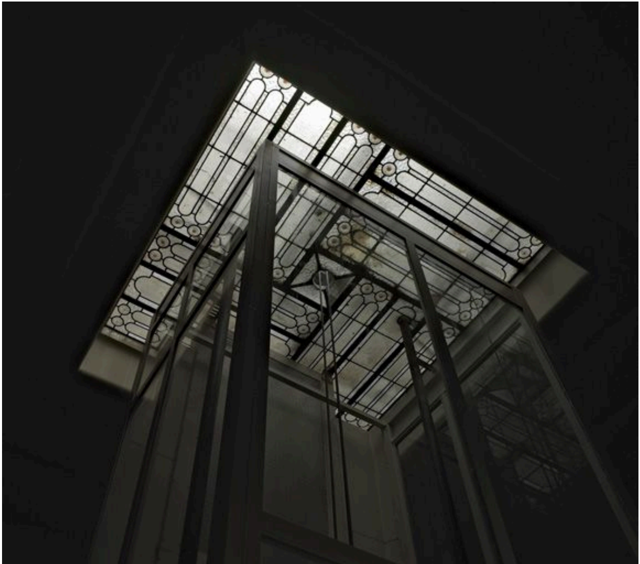
Vue du ciel ouvert de la cage d'escalier
