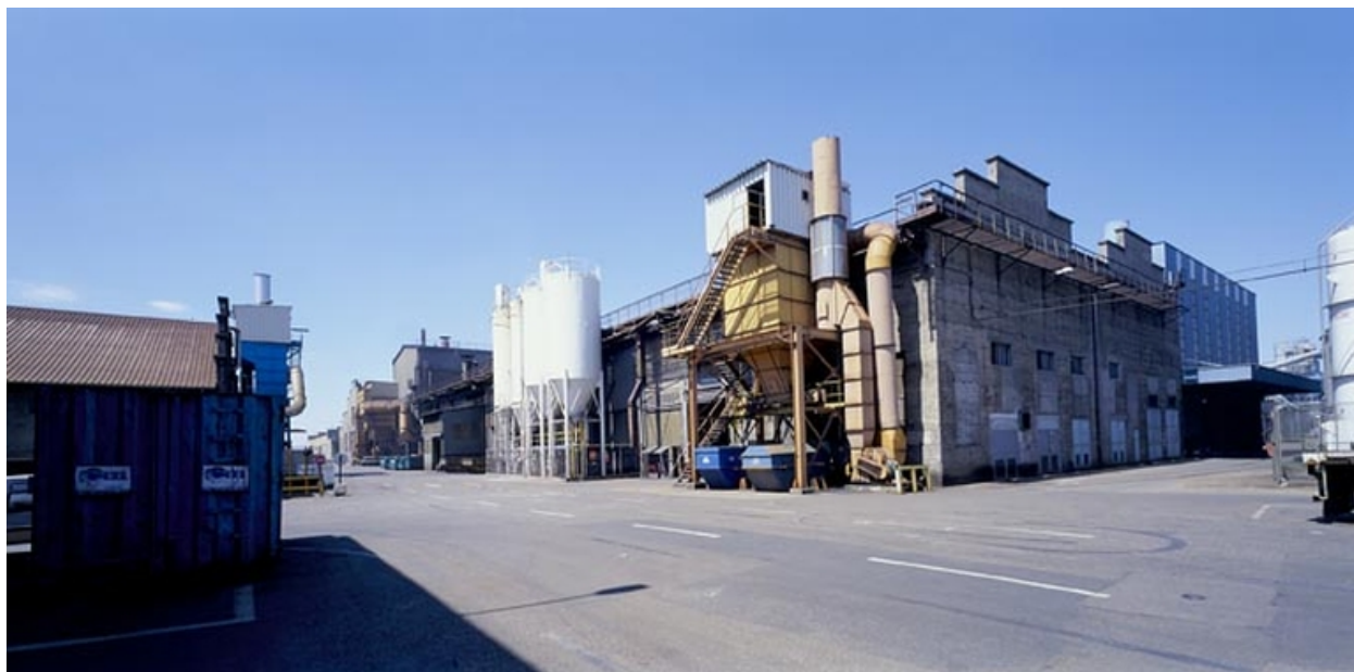
Vue d'ensemble de la fonderie, vue nord
