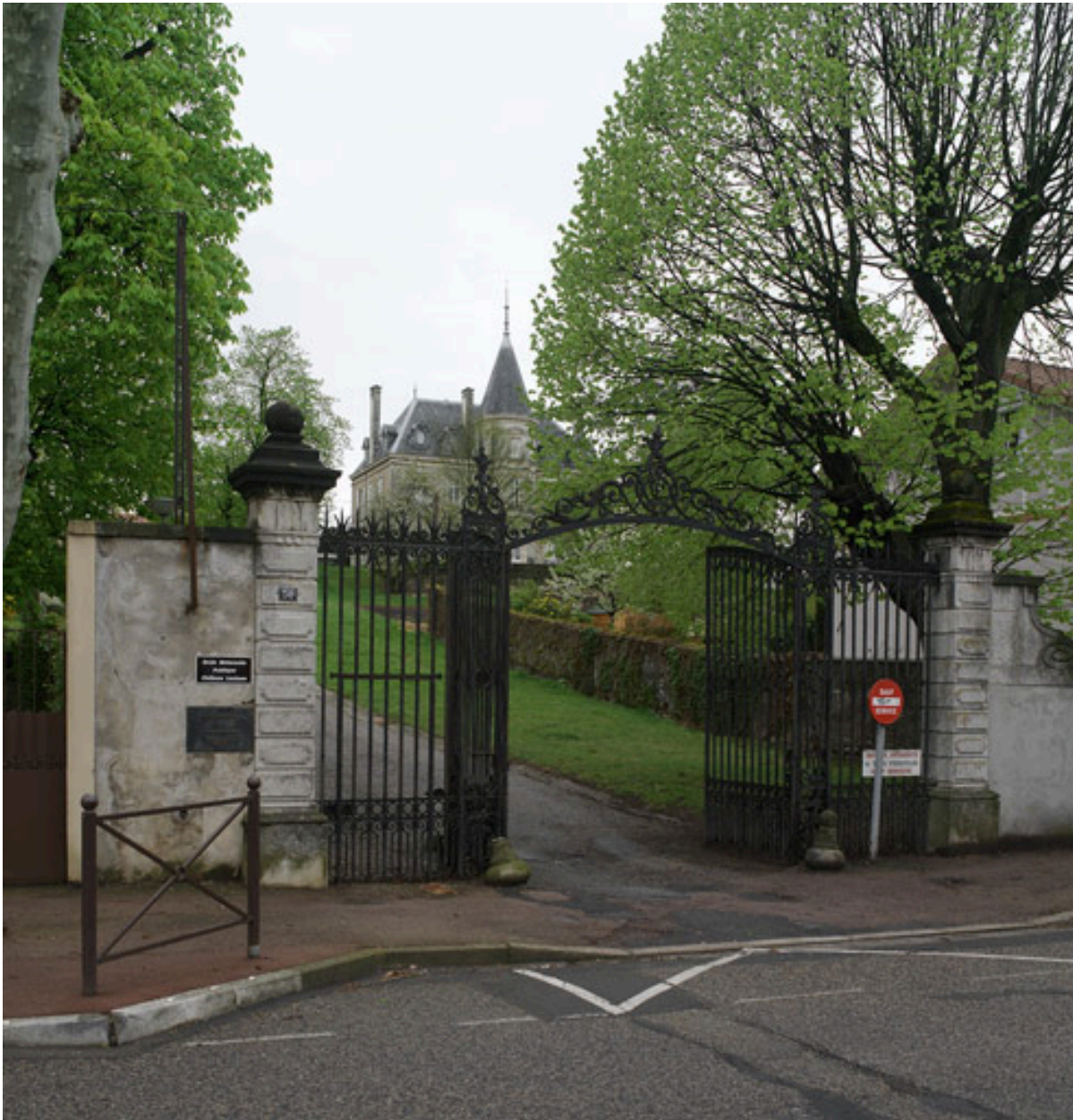
Vue de situation depuis l'avenue d'Alsace-Lorraine.
