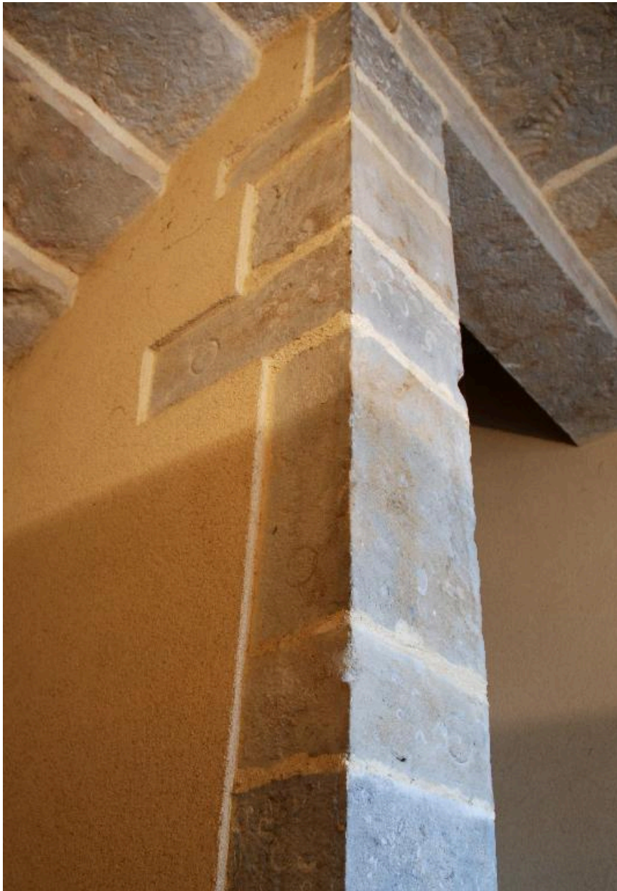
Escalier A, 1er repos : mur noyau.
