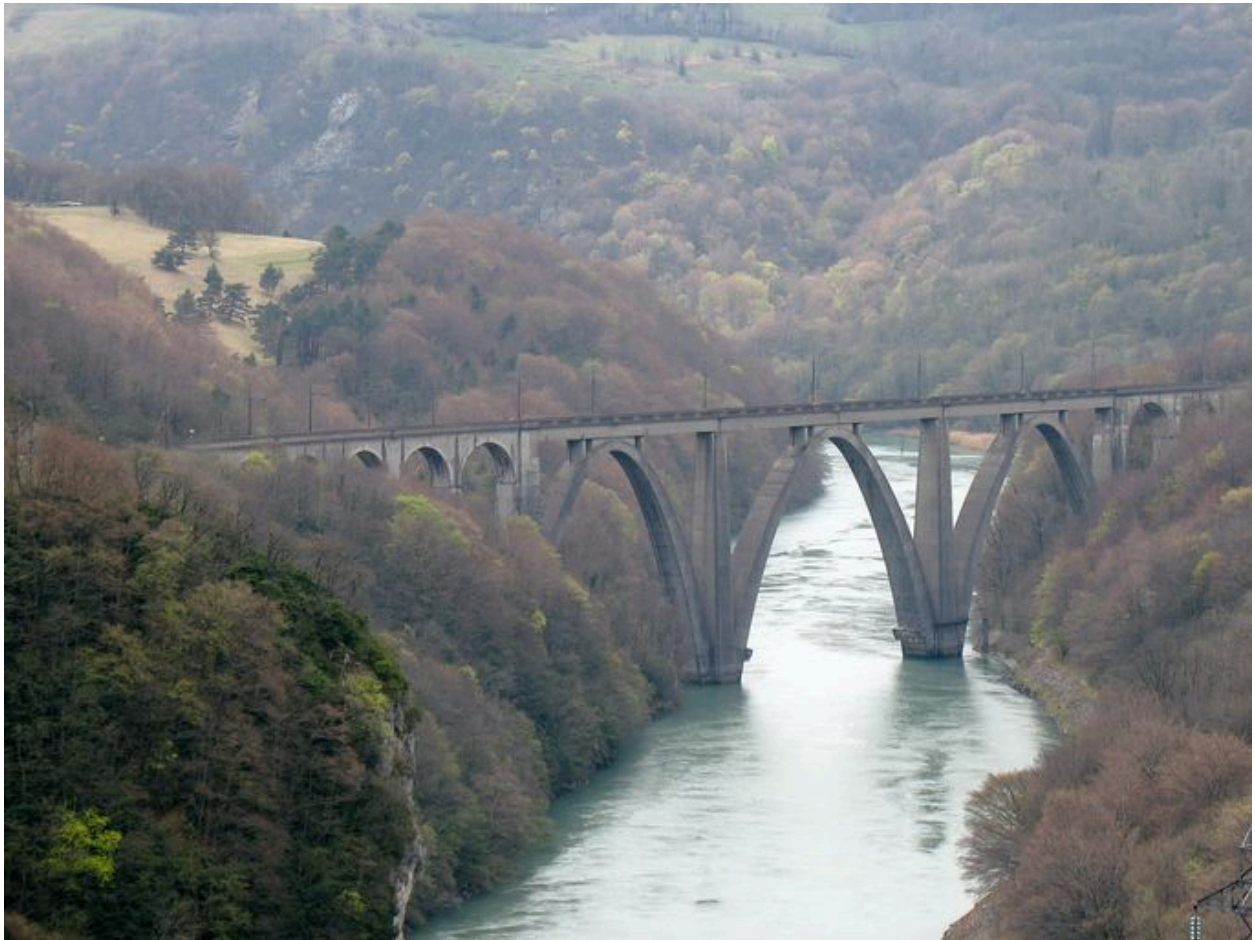
Vue du viaduc ferroviaire de Longeraie (Léaz, Ain) ; pont en arc ajouré (1943)
