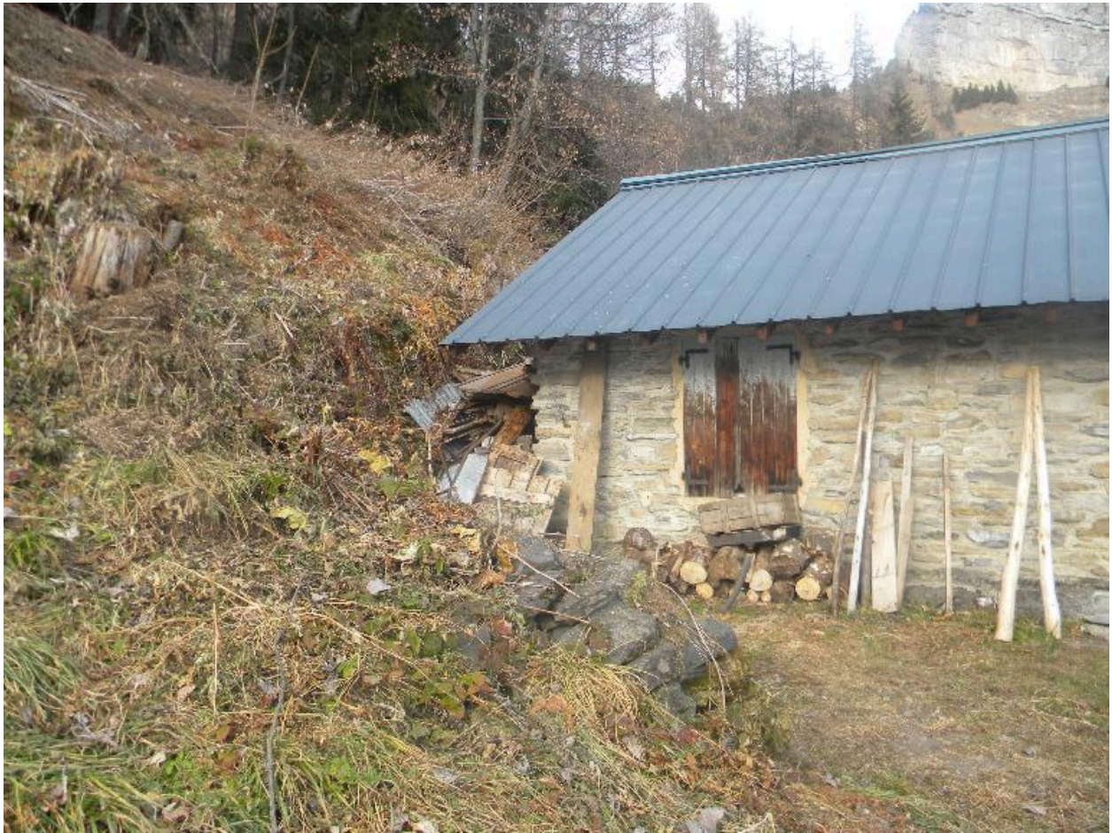
Vue du terrassement muré à l'arrière des bâtiments.
