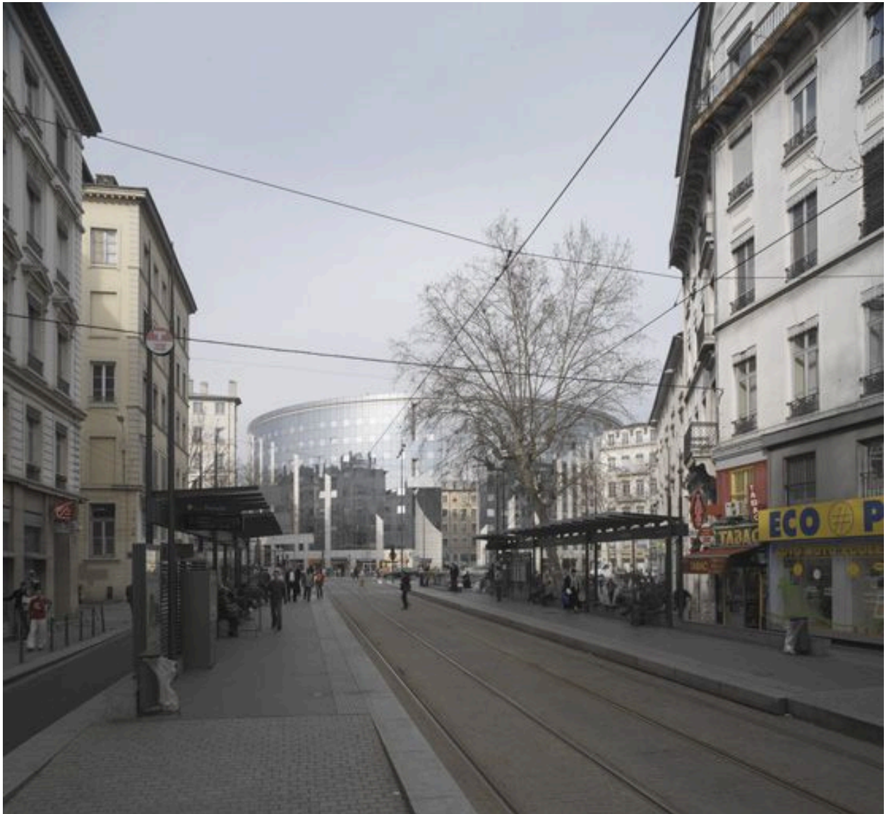
Vue d'ensemble de la place et de la station de tramway, depuis la rue de Marseille au sud
