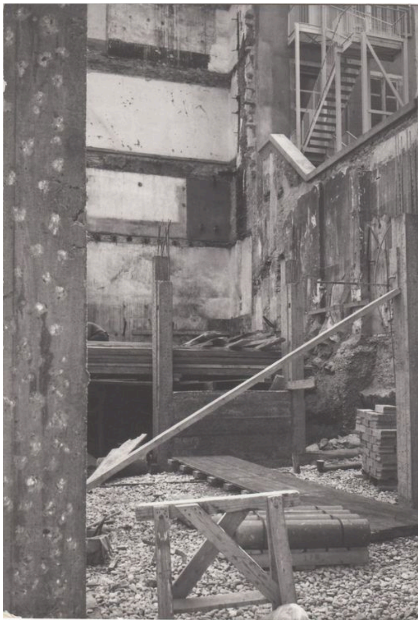
Chantier du bâtiment ISARA (2nd phase), photographie ancienne, 1972
