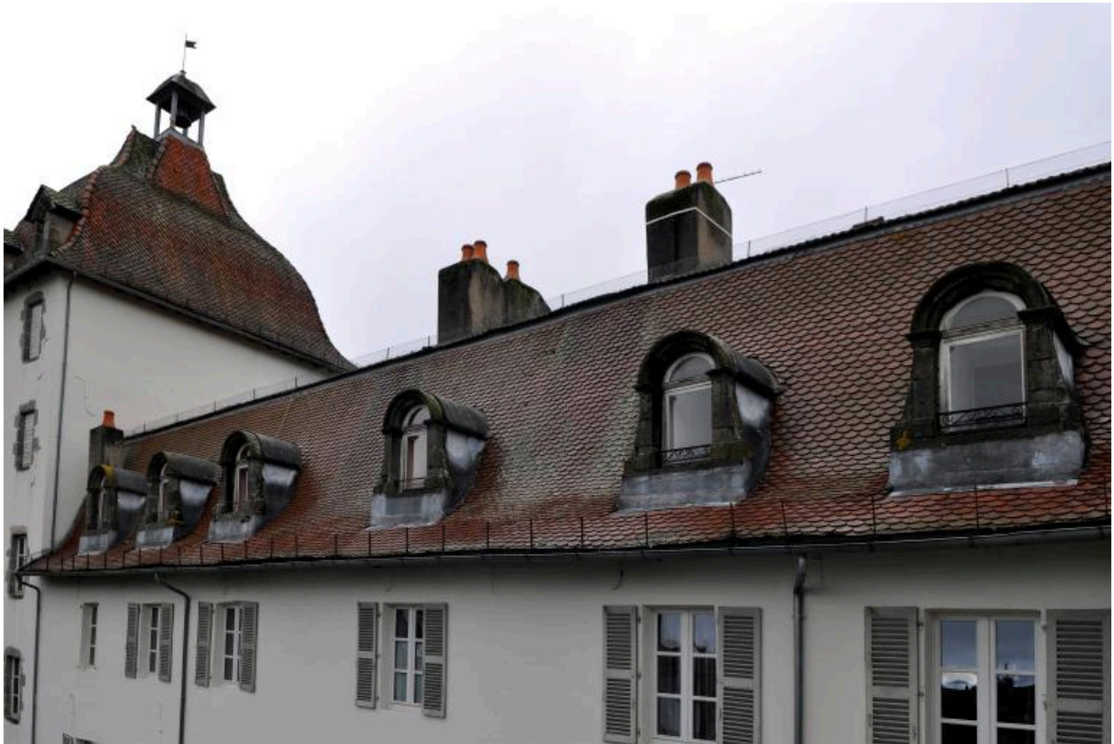
Bâtiment C : détail du toit de l'aile est
