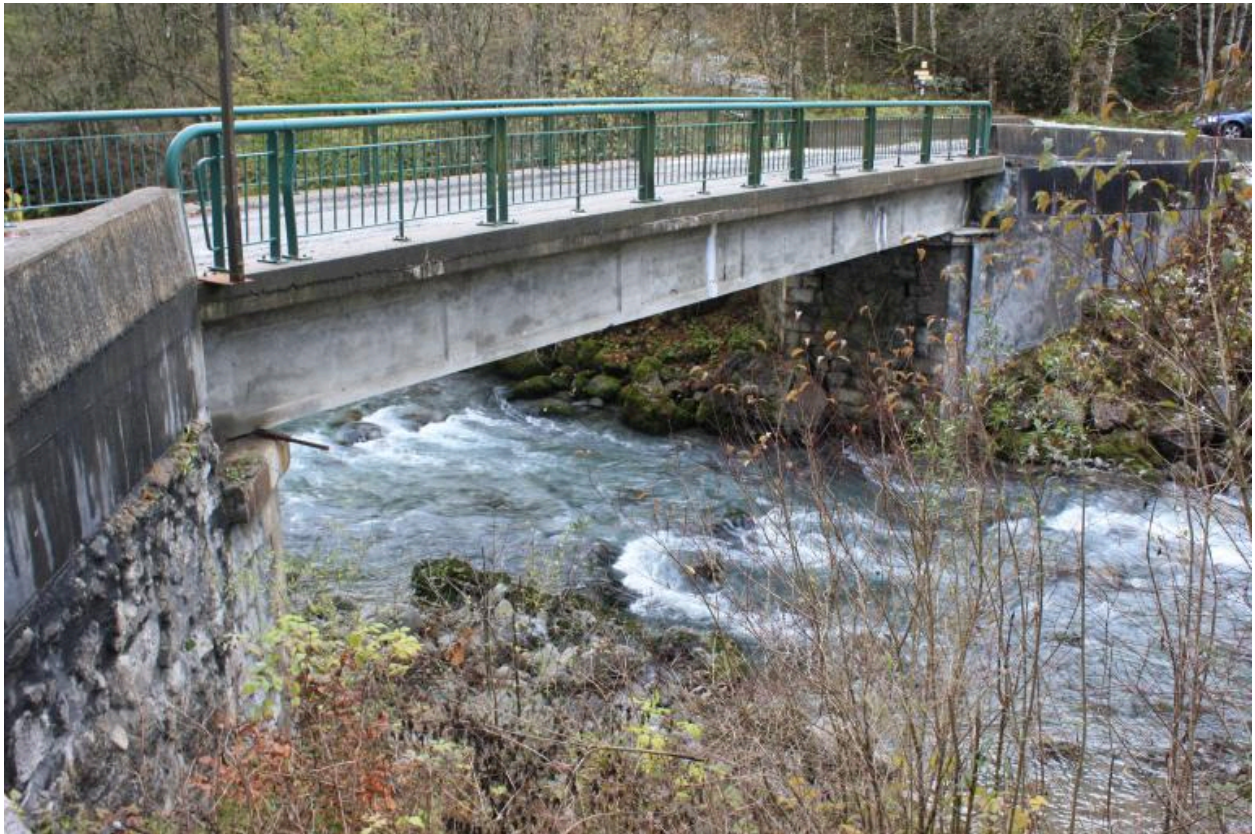
Pont de la Moussière, face en aval
