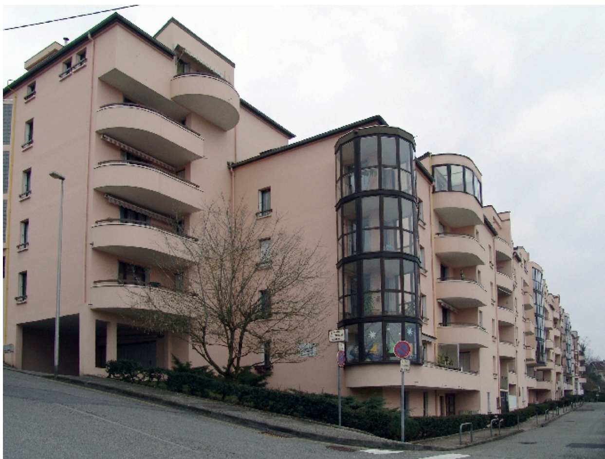
Vue prise du sud
