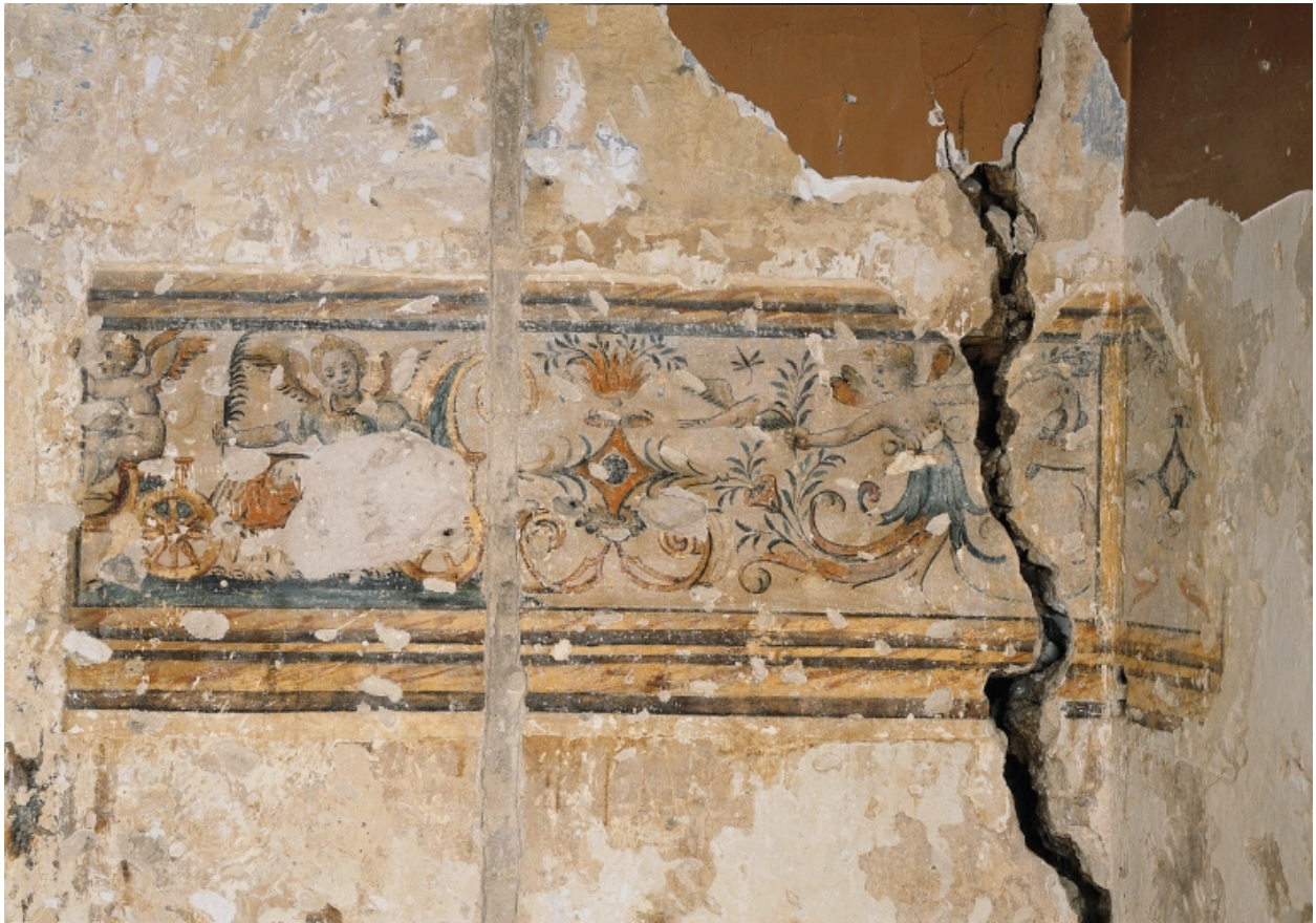
Vue d'ensemble in situ, lors du dégagement.
