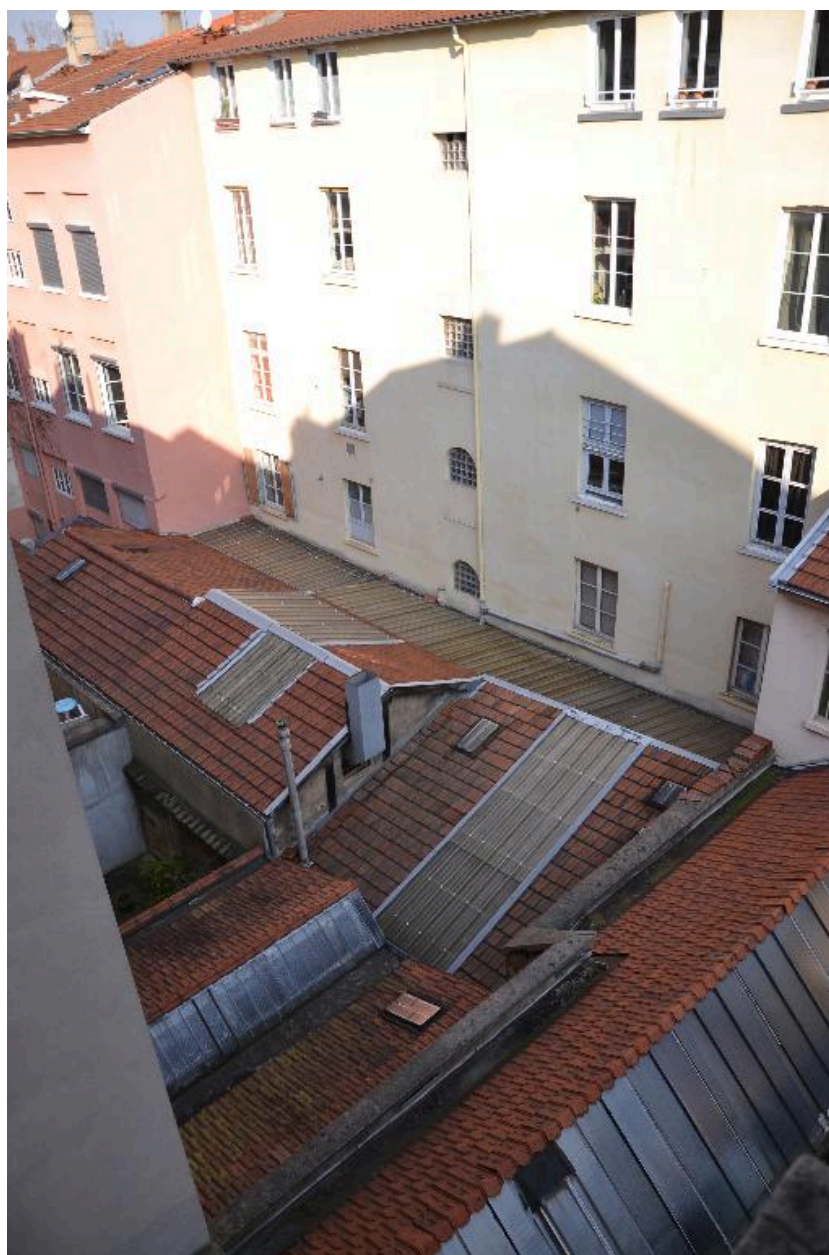
Vue depuis l'immeuble
