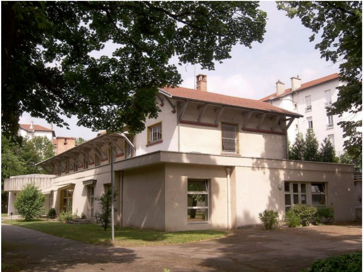
Batiment Nord Ouest, elevation trois quart droite
