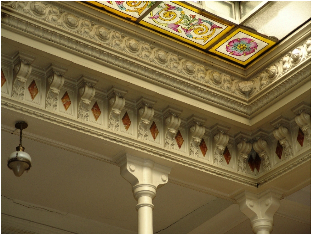
Verrière de l'atrium
