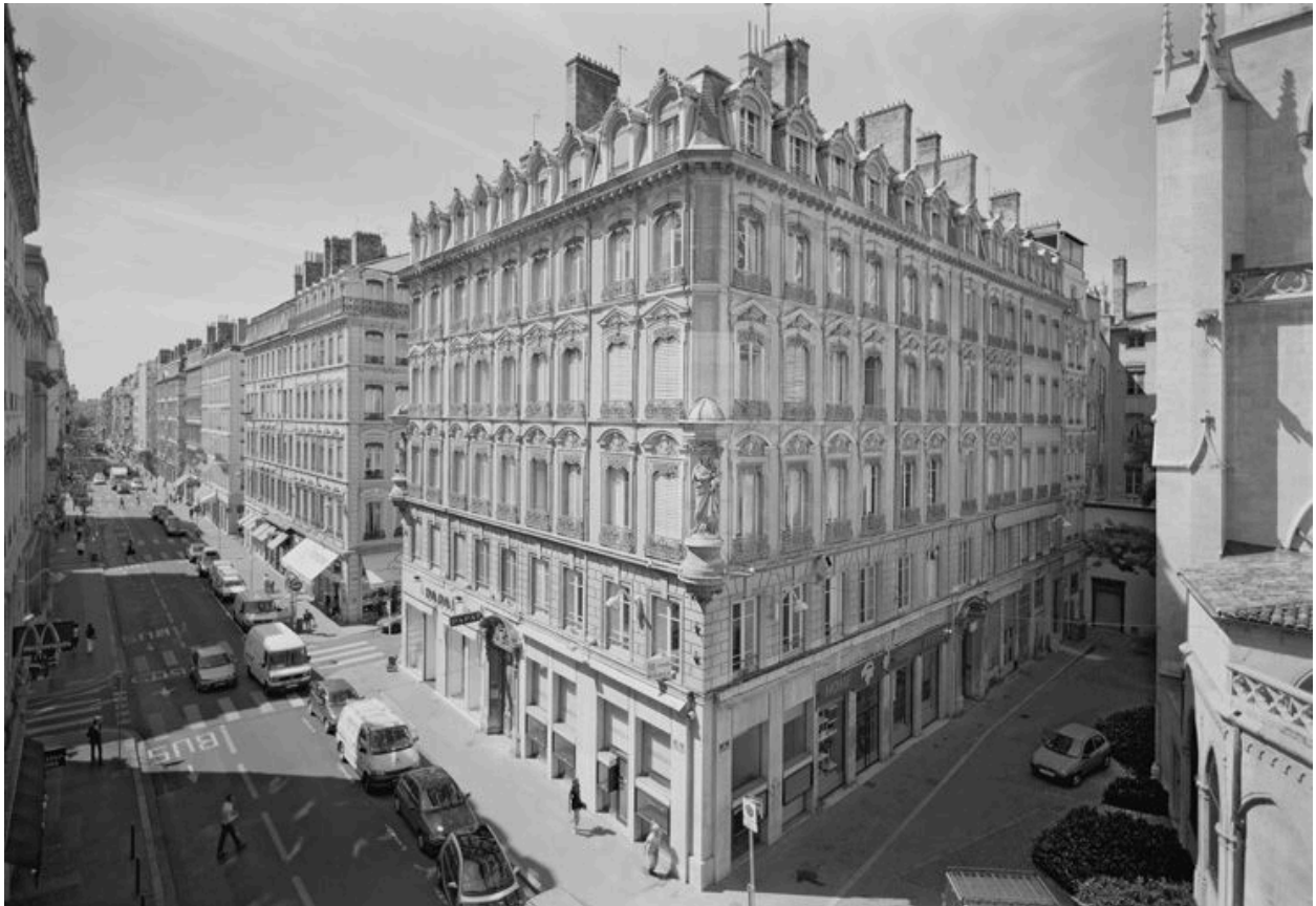
Vue générale de situation
