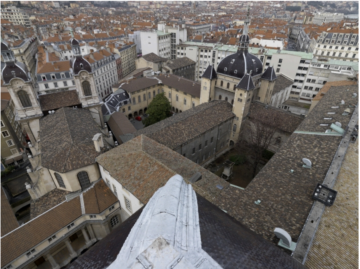
Vue depuis le sud-est. Le dôme des Quatre Rangs et les quatre corps de logis, la cour d'Honneur, la cour de l'Arbre et la chapelle
