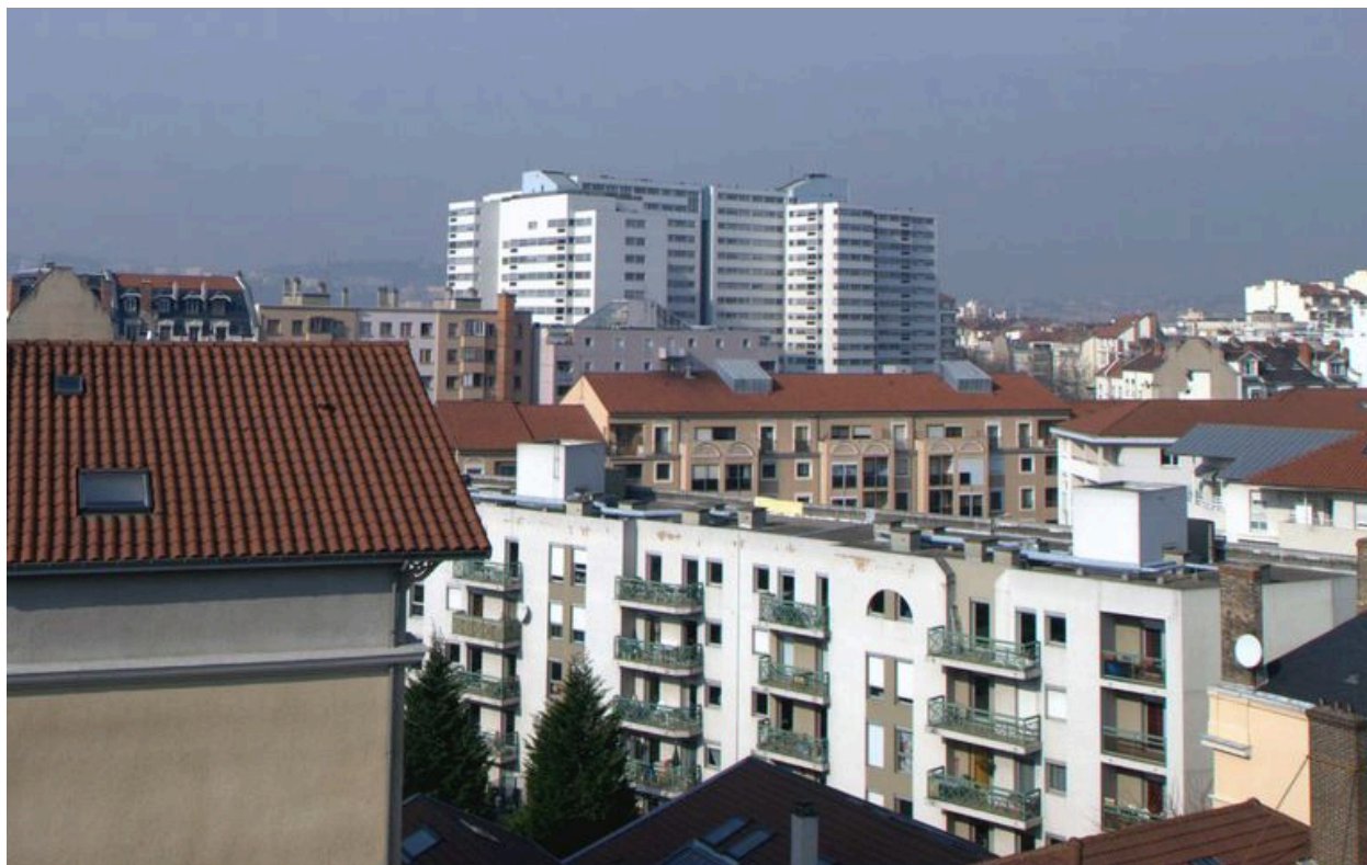
Elévation postérieure, vue partielle depuis le sud-est
