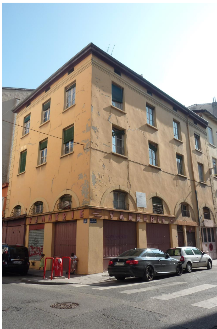
Vue générale de l'immeuble 9 rue du Chariot d'Or
