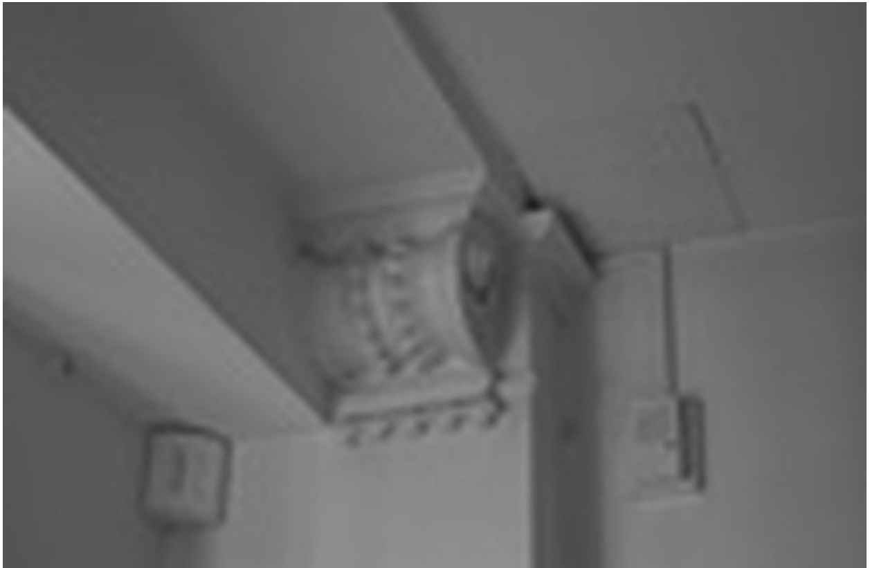
Corps de bâtiment principal, escalier desservant les étages carrés : détail
