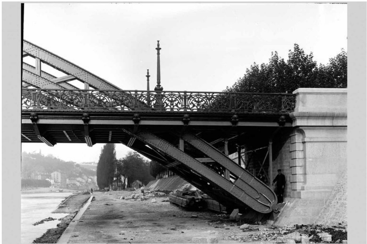
Le pont de la Boucle achevé. La travée de rive, rive gauche depuis le sudl. Photogr., [1903] (Arch. mun. Lyon. 15 Ph 1840)
