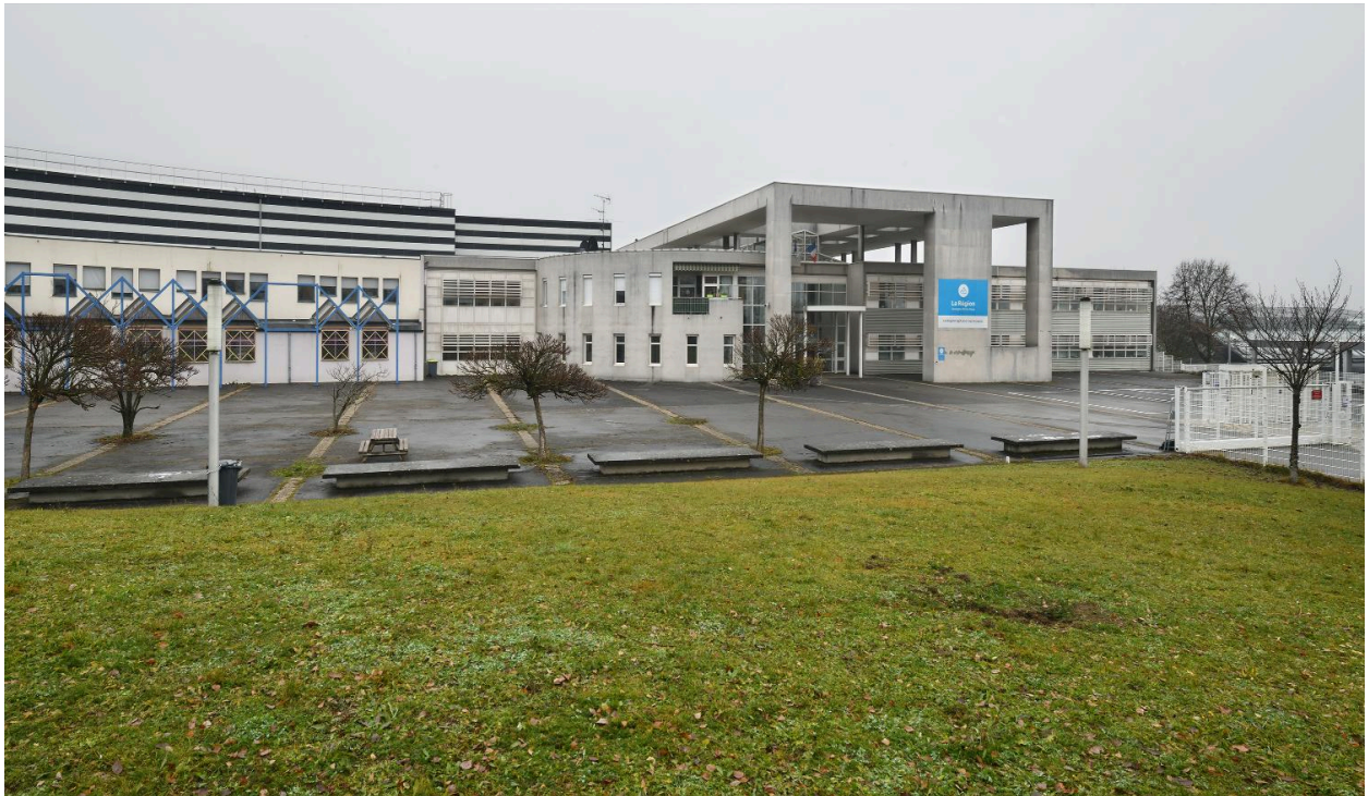
Vue d'ensemble et entrée du lycée
