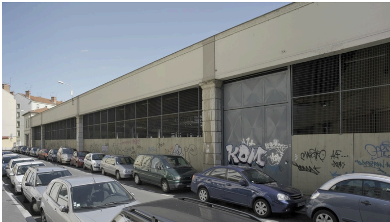
Façade nord-ouest, rue d'Anvers, entrée des véhicules
