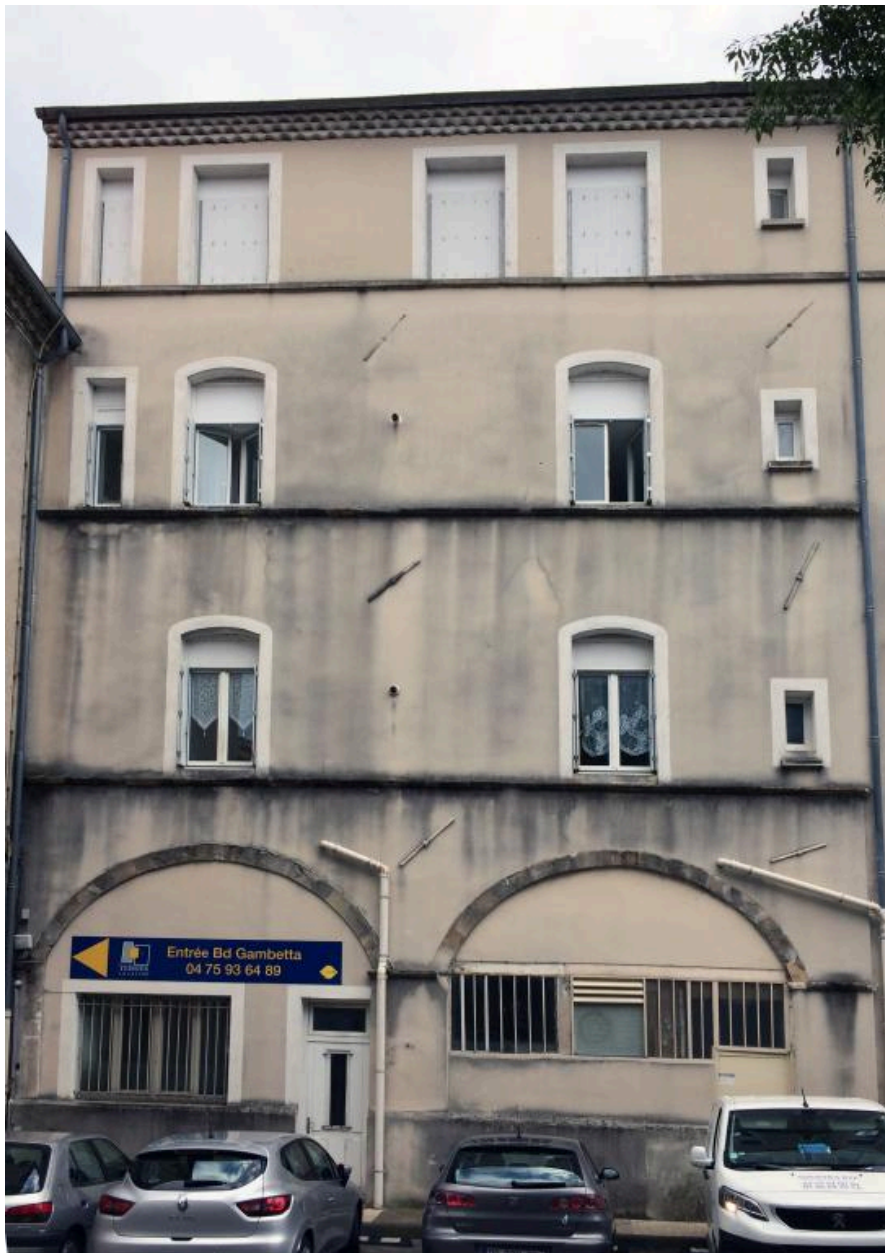
Ancienne élévation nord sur cour : détail des deux travées nord
