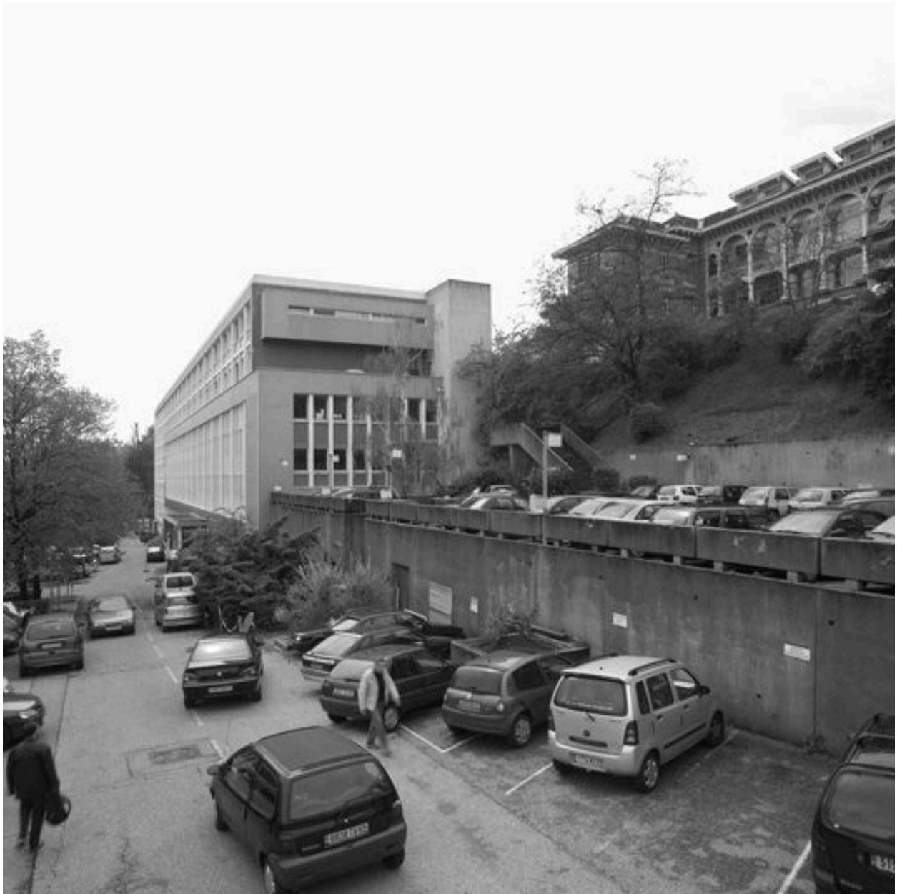
Bâtiment A, façade nord
