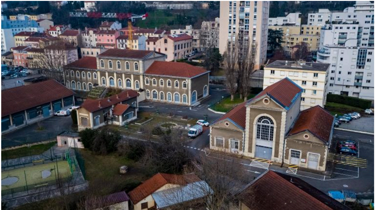
Vue d'ensemble de l'usine des eaux de Saint-Clair (drône)
