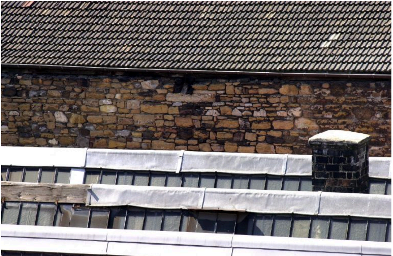
Détail des matériaux de gros oeuvre du hangar central
