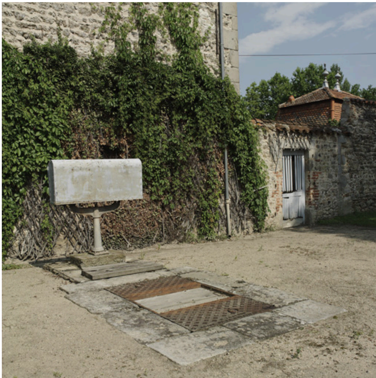
Vue d'ensemble du pont bascule.
