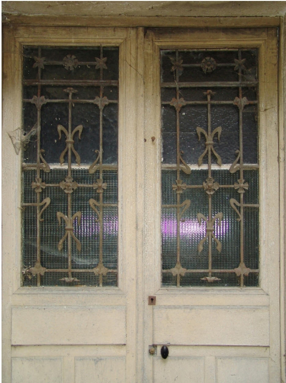
Ferronnerie d'une porte de service
