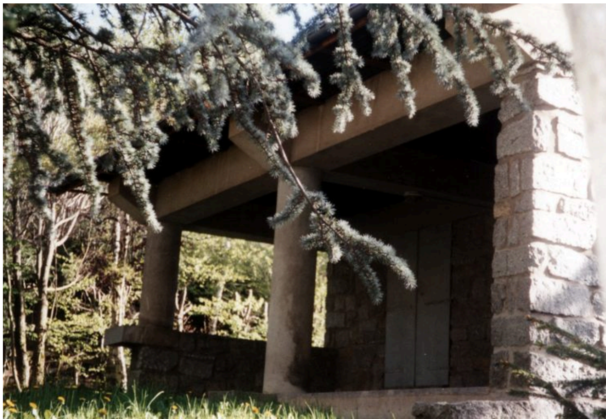
Façade est. Le porche. Etat en 1996
