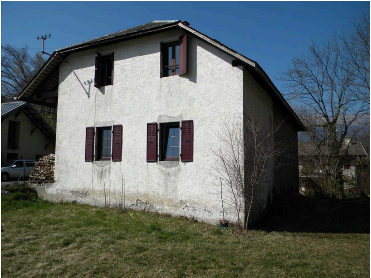
Vue du pignon est.
