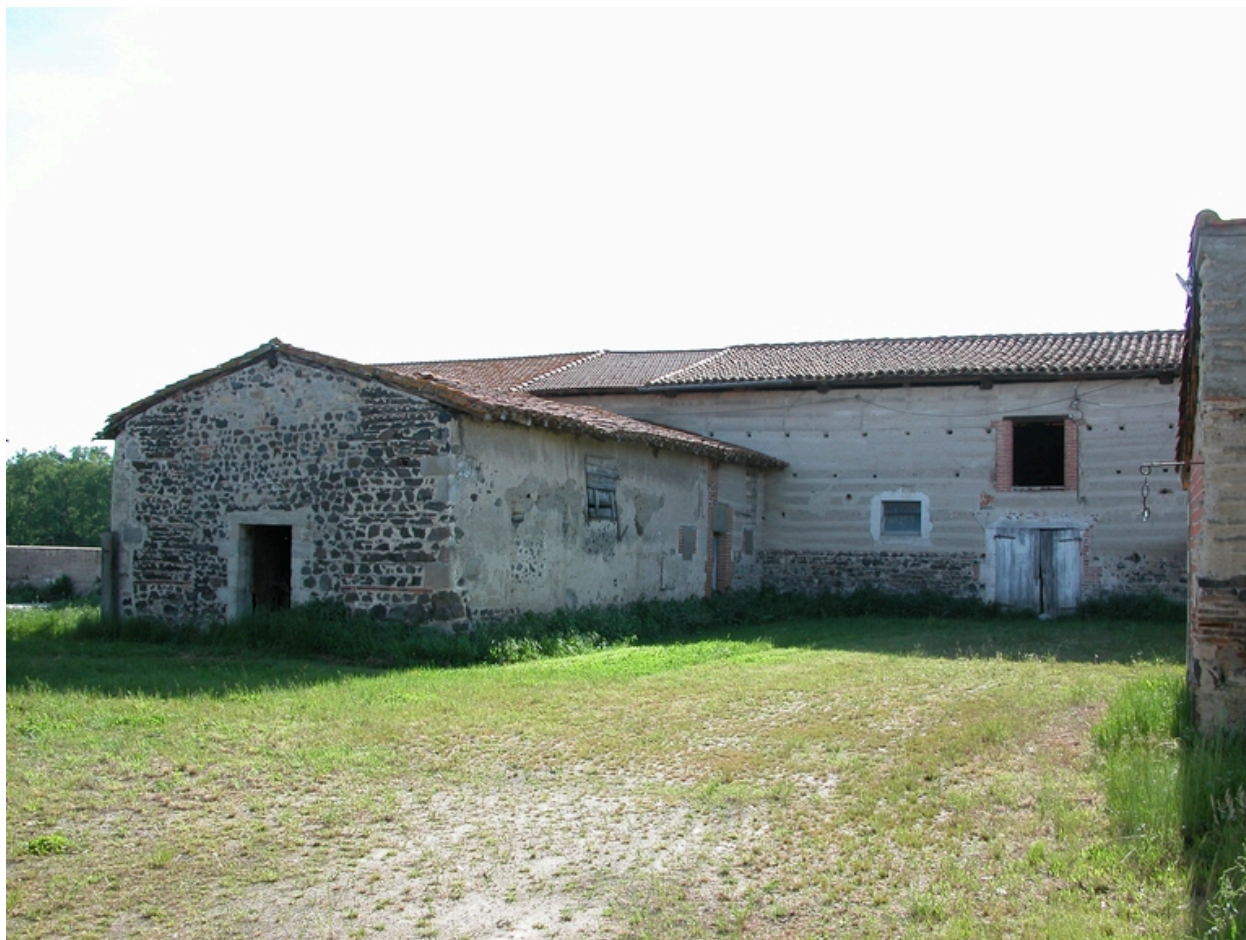
Vue de la grande grange-étable et de la porcherie, depuis la cour.
