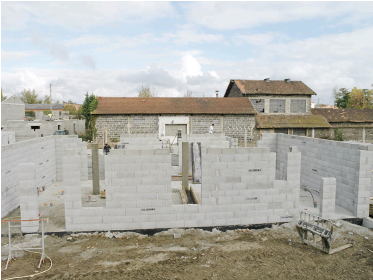
Près du Palais, 1986 AH 53a. Pavillons en construction.
