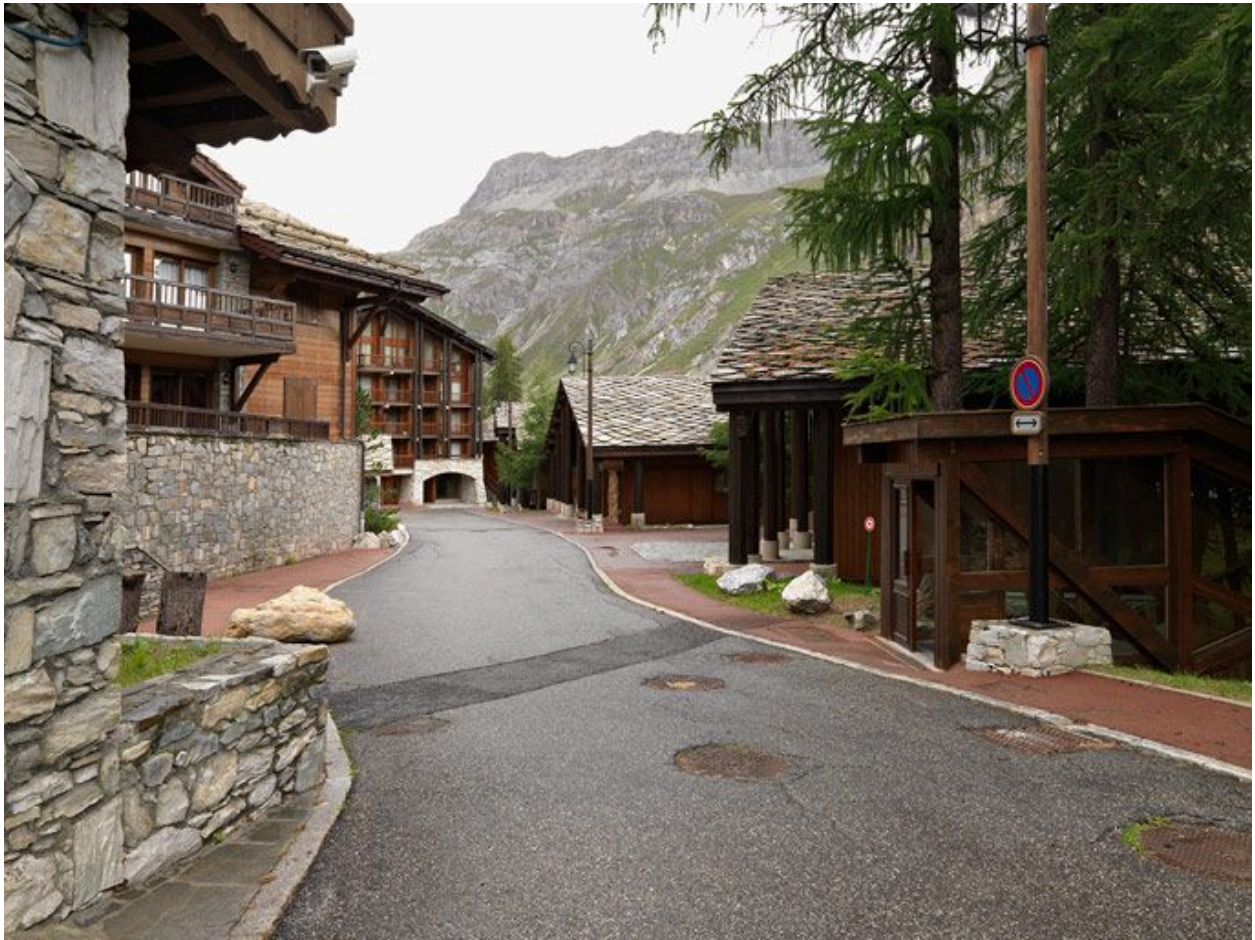
Quartier de Val Village à Val d'Isère (Savoie), Jean-Louis Chanéac architecte-urbaniste, 1989
