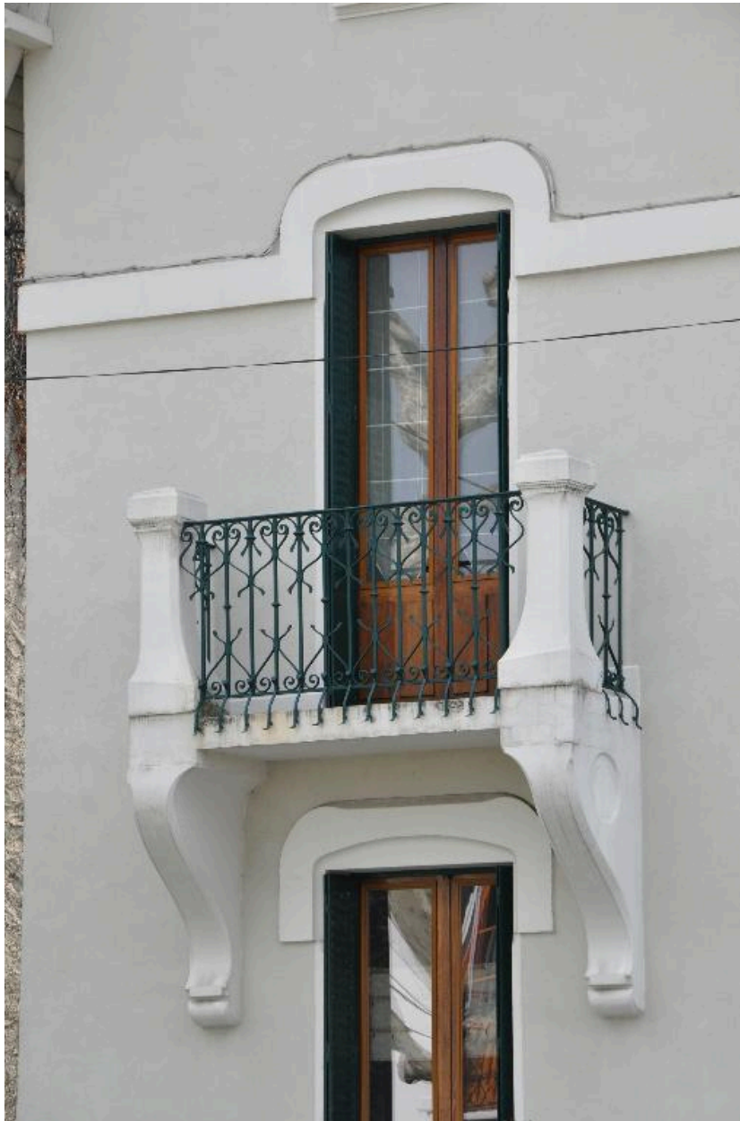
Balcon avec piliers et consoles moulés
