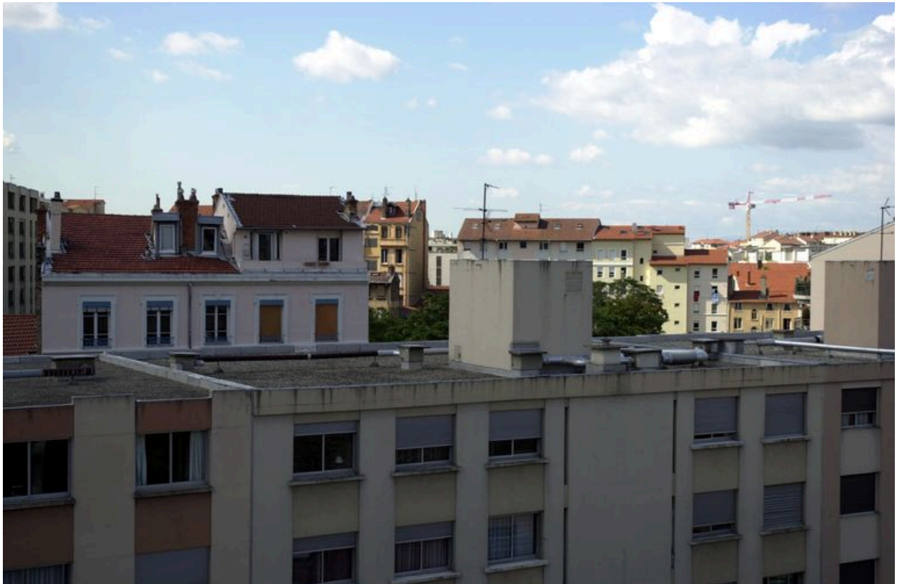
Vue du toit terrasse
