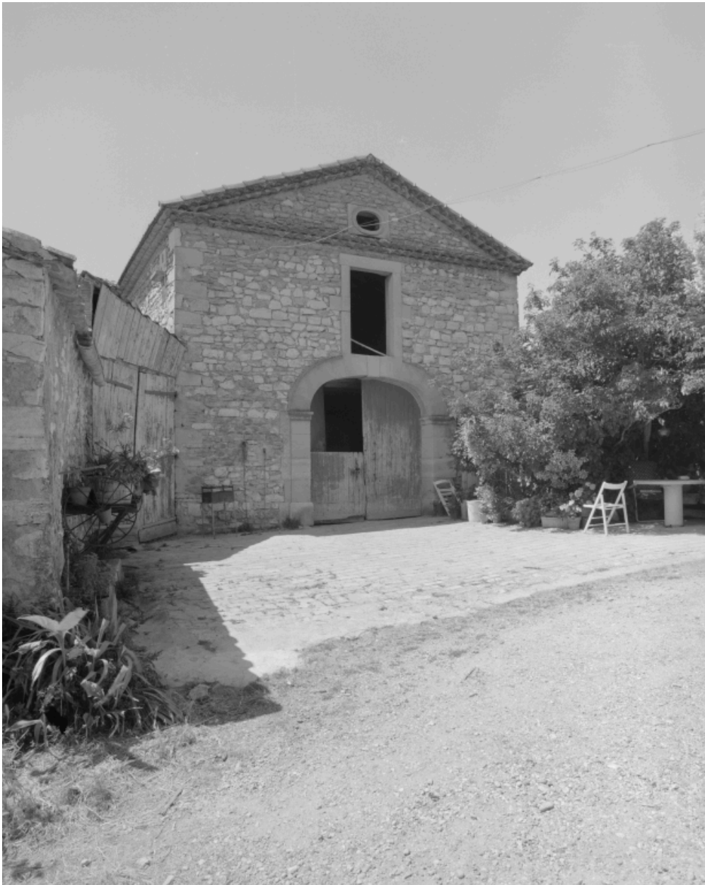
Etable-remise et fenil : exemple de dépendance d'une maison du hameau (H1 34).
