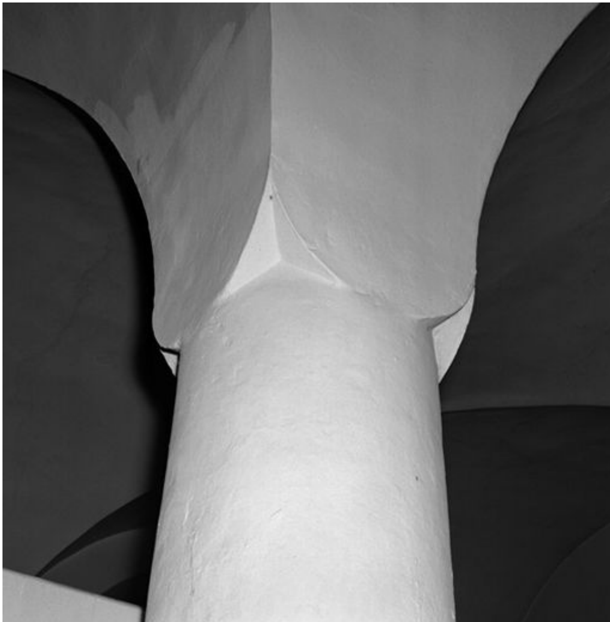
Corps principal, chapiteau d'une pièce du rez-de-chaussée
