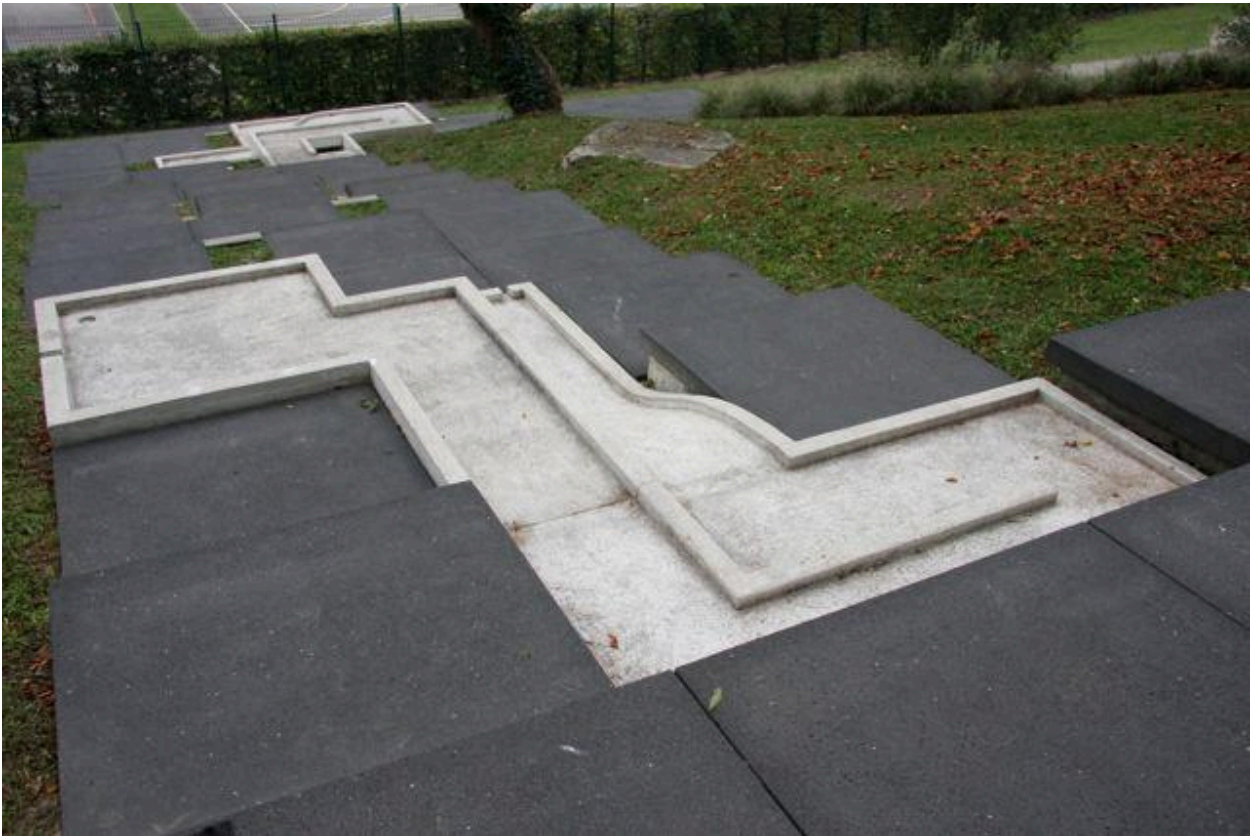
Vue d'ensemble, depuis le haut
