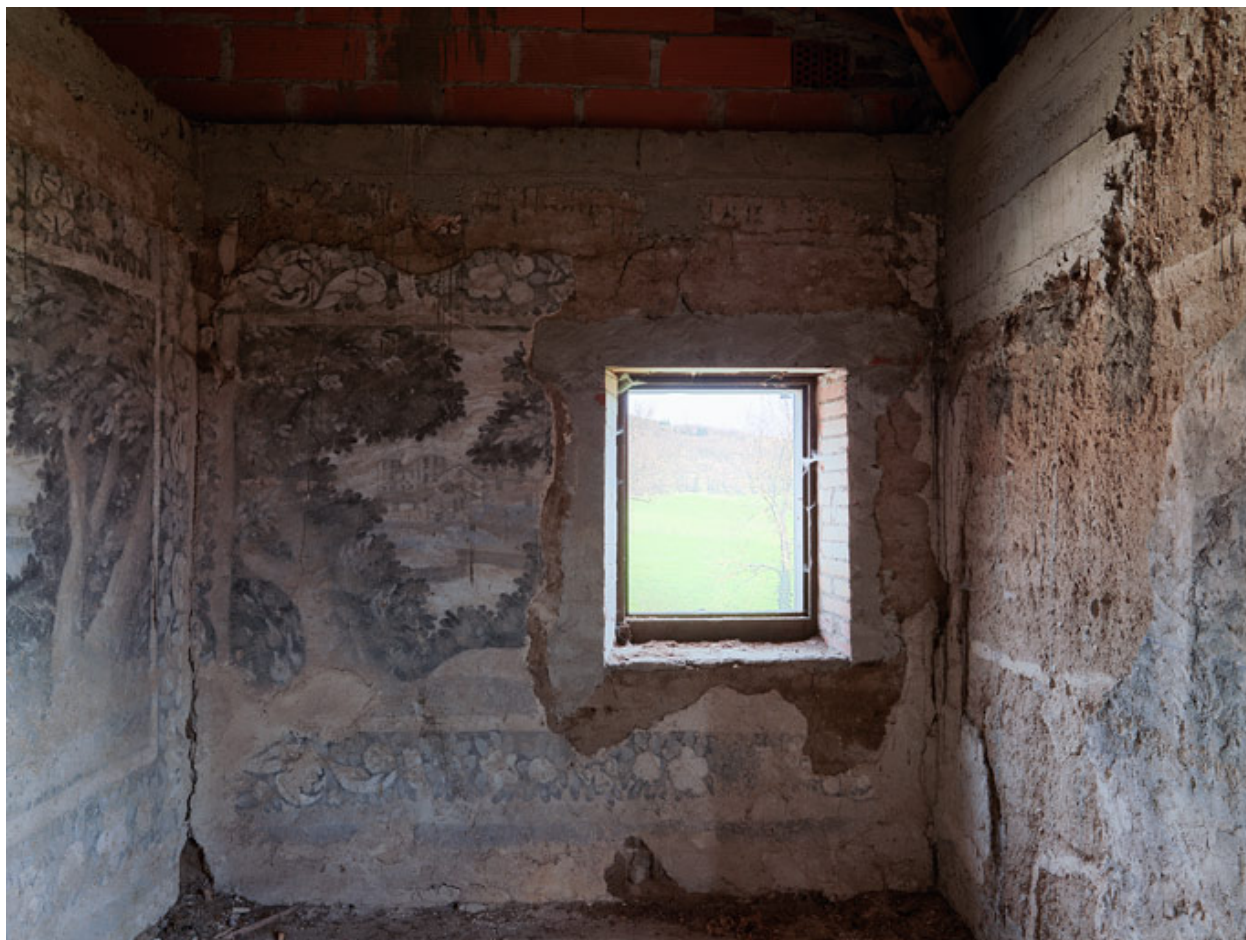
Vue intérieure du 2e étage : peintures murales.
