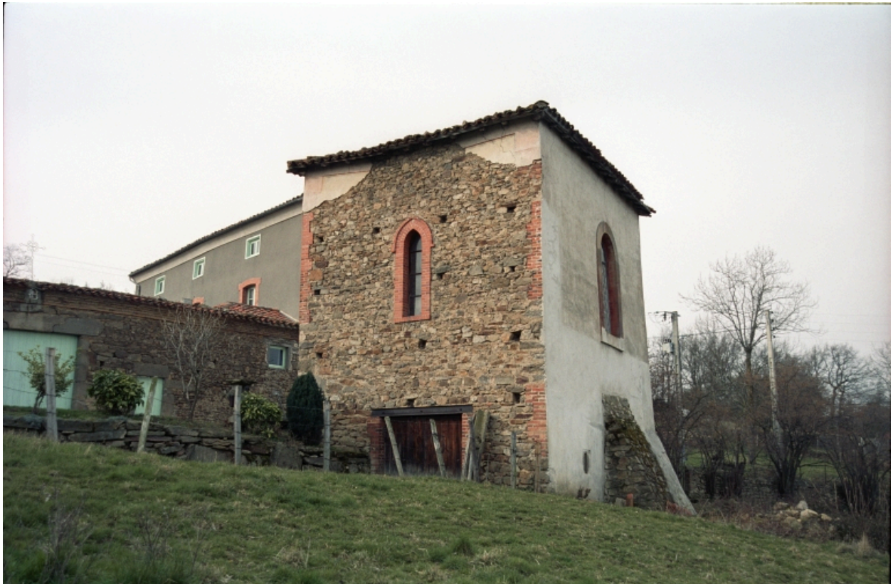
Vue d'ensemble de la chapelle depuis le nord-est.
