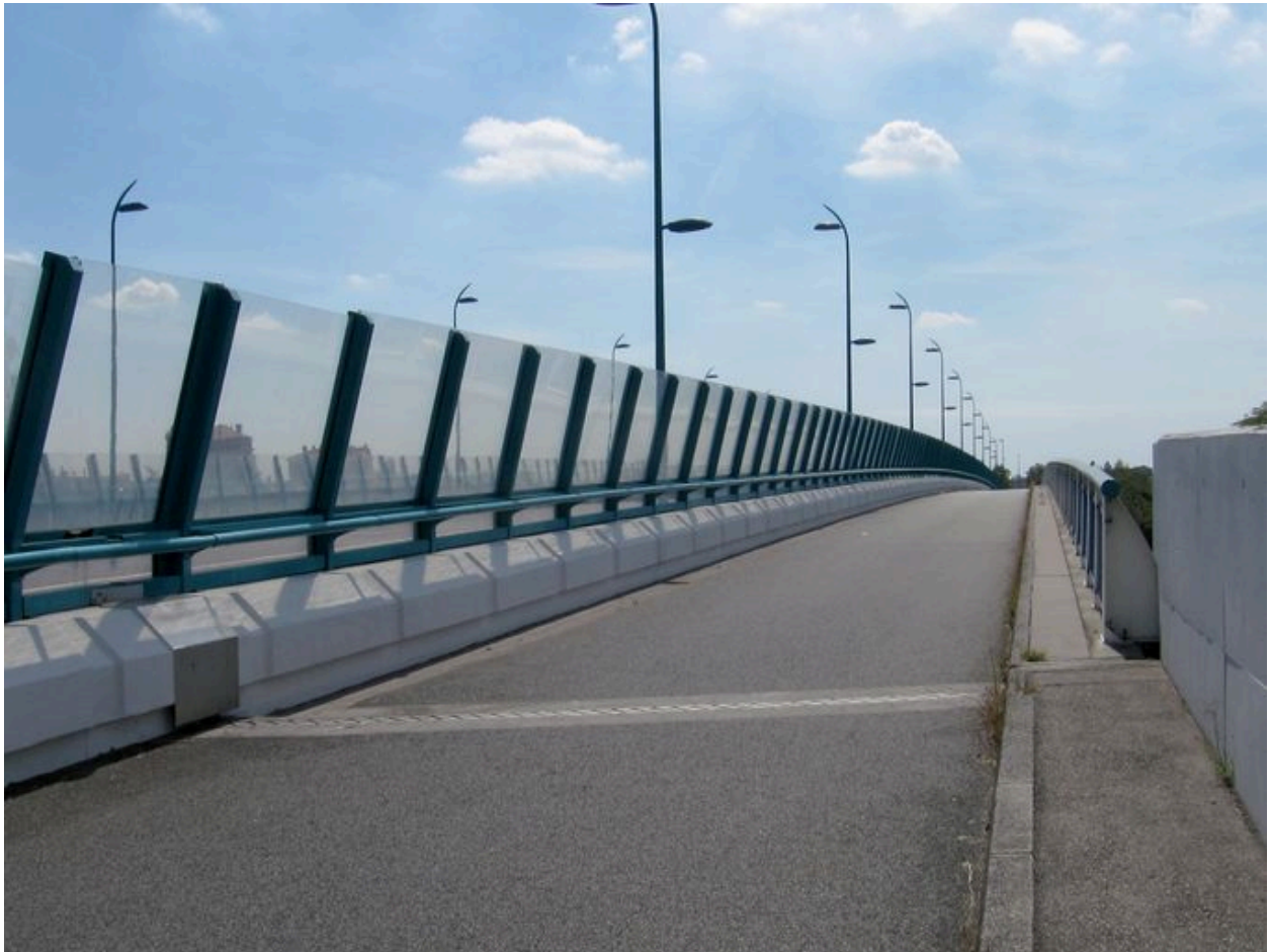
Vue partielle, de dessus, voie piétonne, face aval (depuis la rive droite)
